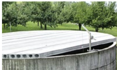
Abdecken der offenen Güllebehälter mit Spannbeton. Bild: Kohli AG
