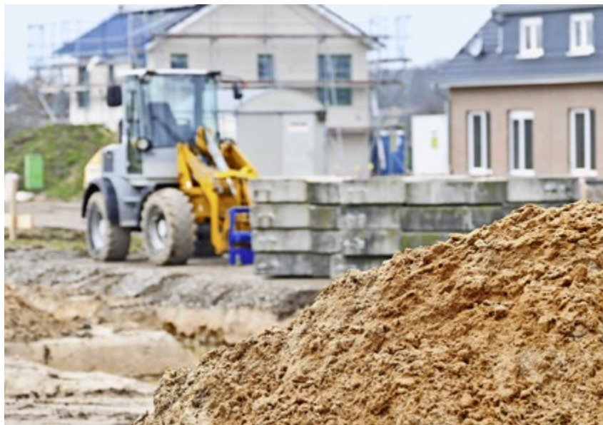
Bewilligungen für Bauvorhaben sind vorgängig einzuholen. Bild: Pixabay
