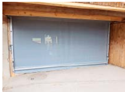
Mit der Montage eines Windschutznetzes kann ein Bereich im Stall windgeschützt gestaltet werden. Bild: Karoline Schweingruber
