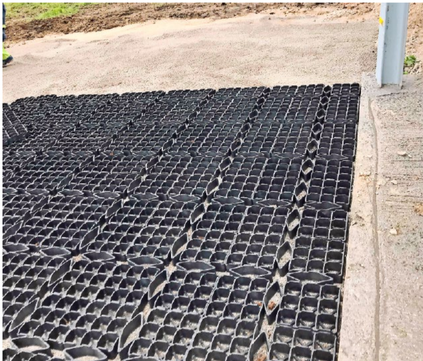
Die Befestigung der Weideeingänge kann eine Möglichkeit sein, kann das Problem aber auch einfach um ein paar Meter verschoben. Bild: Strickhof
