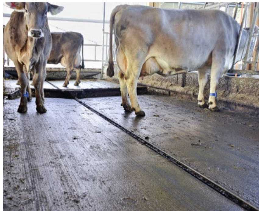
Planbefestigte Laufflächen mit Quergefälle (3 Prozent) und Harnsammelrinne ermöglichen ein rasches Abfließen des Harns von der Lauffläche. Bild: Agroscope
