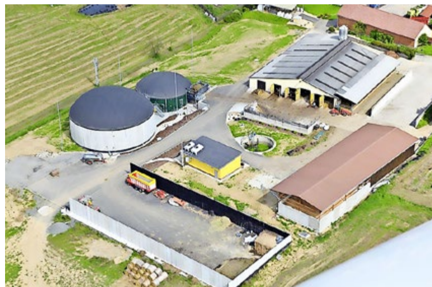
Luftaufnahme des Betriebs. Bild: zVg
