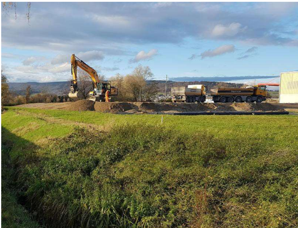
Die Menge an Kies, der bis zu 1,3m Höhe aufgeschüttet worden ist, entspricht mehr als 500 Transportfahrten mit einem 5-Achs-Kipper. Bild: ZBV
