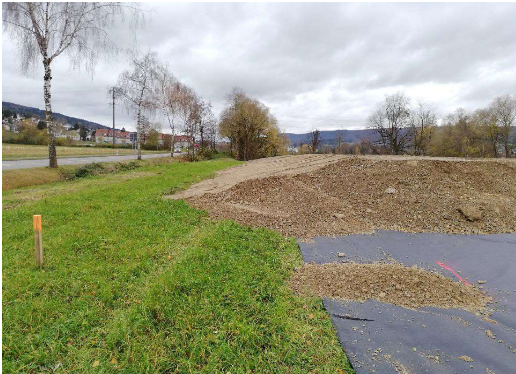
Rd. 10'000m 3 Kies wurde auf der Wiese, die durch eine Folie abgedeckt wurde, deponiert. Bild: ZBV
