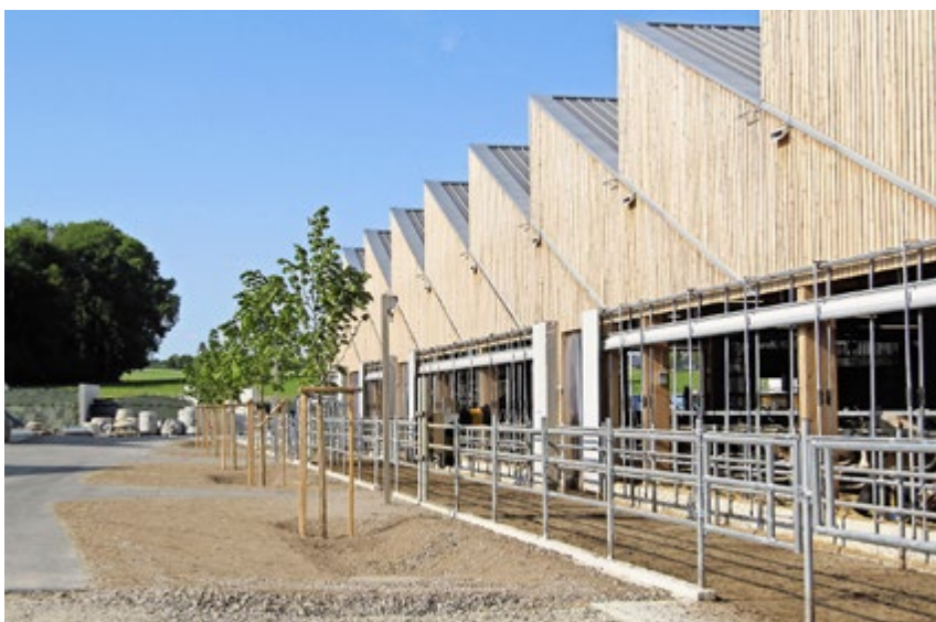
Am nächsten Mittwoch findet auf dem Ausbildungs- und Versuchsbetrieb AgroVet-Strickhof der 4. Puure-Höck statt. Bild: Strickhof
